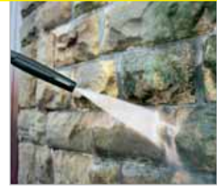
Бережная очистка каменных стен
